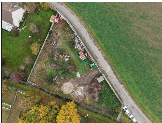
L'emplacement retenu : l'ancien site de la station d'épuration
