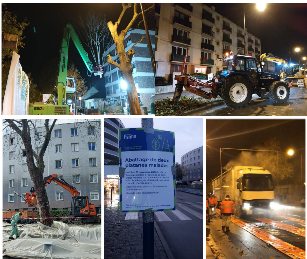
Prises de vue à l'occasion de chantiers d'abattage franciliens (photos DRIAAS-SRAL)
