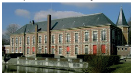
Façade conservée de Style Louis XIII
